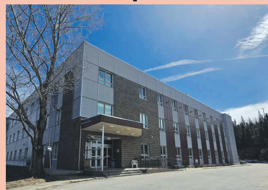
Le CHSLD Boisvert est visé par une enquête de la CNESST. Photo Karianne Nepton-Philippe
