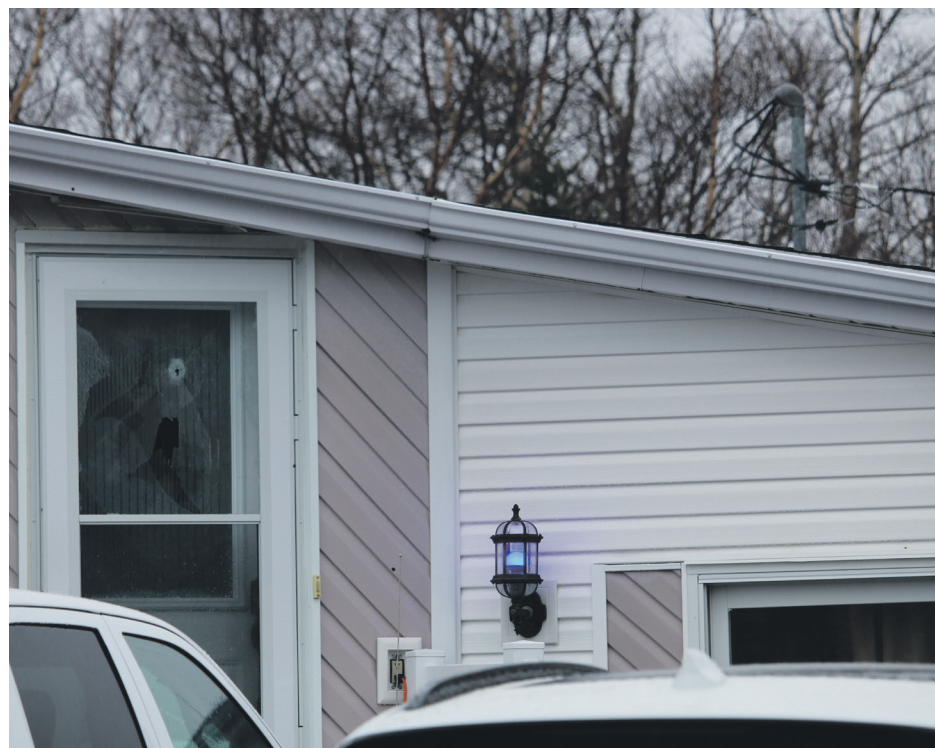
La maison d'un couple d'aînés a été fusillée par erreur, le 23 avril, vers 21 h 30, à Moisie. Photo Sylvain Turcotte
